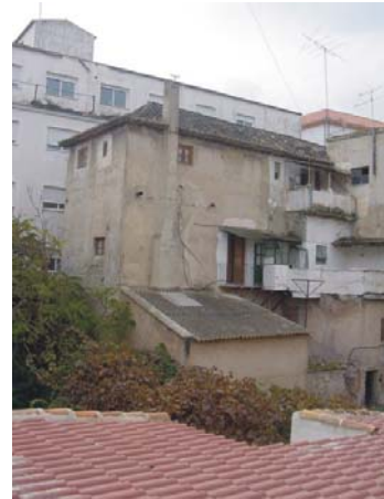
Trasera de la edificación hacia el huerto.
