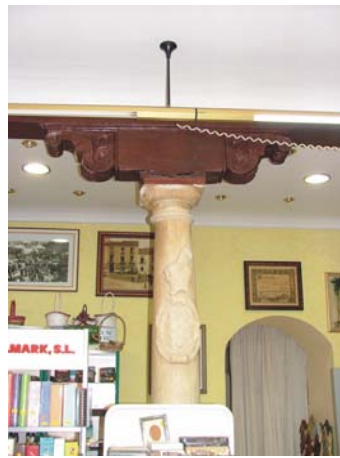
Columnas labradas y zapatas del patio cegado
