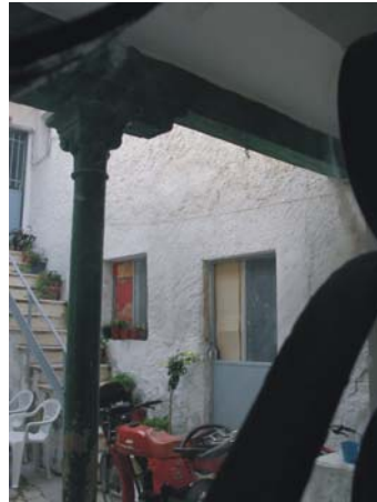
Vista interior de columna en patio principal
