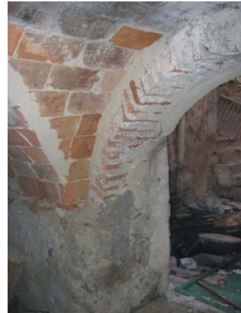
Acceso al patio desde una de las bóvedas del semisótano.
